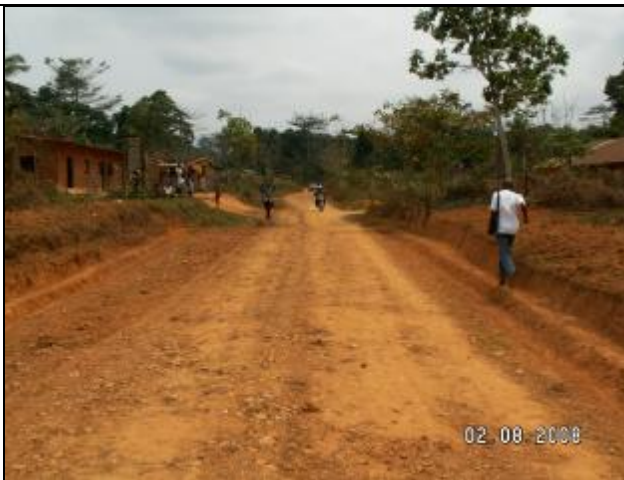
Début des travaux de réhabilitation sur la piste n° 25 (Tshela-Loango Kheni).
